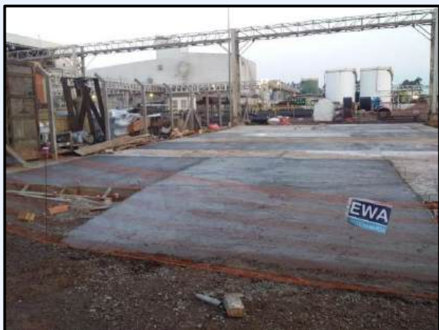
Execução de Piso de Concreto Armado
