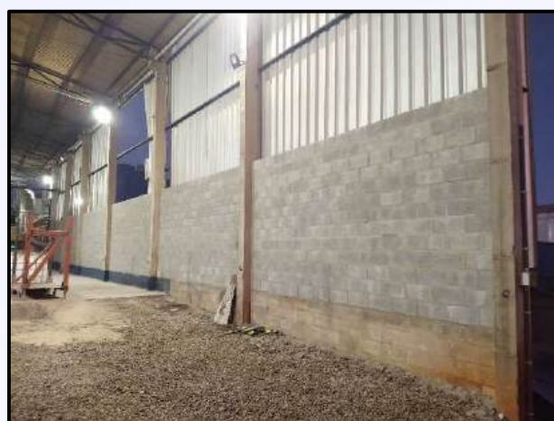
Construção de Parede de Vedação em Blocos de Concreto
