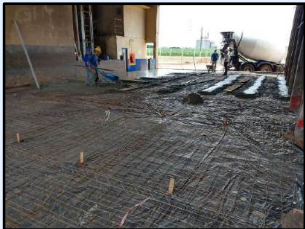
Execução de Piso de Concreto Armado
