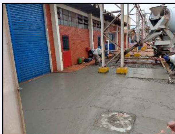
Reparos em Piso de Concreto Armado
