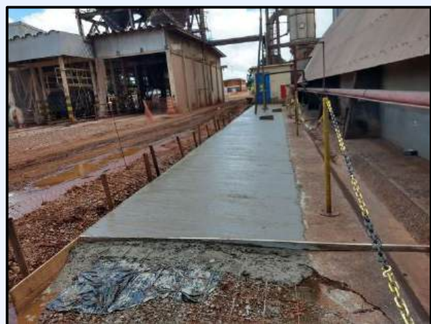
Execução de Piso de Concreto Armado
