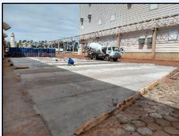
Execução de Piso de Concreto Armado
