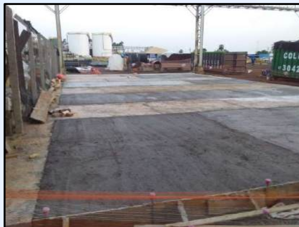
Execução de Piso de Concreto Armado
