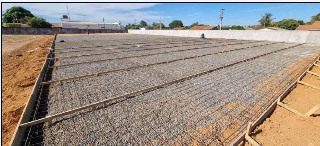
Construção – Obra de Quadra Poliesportiva
