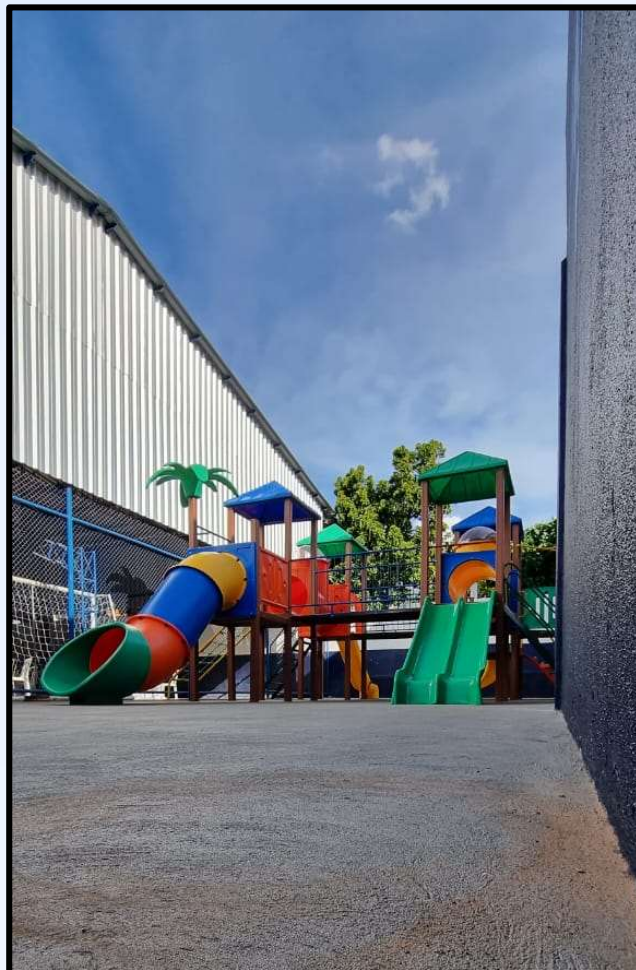
Reforma e Ampliação de Escola
