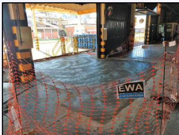
Reparos em Piso de Concreto Armado
