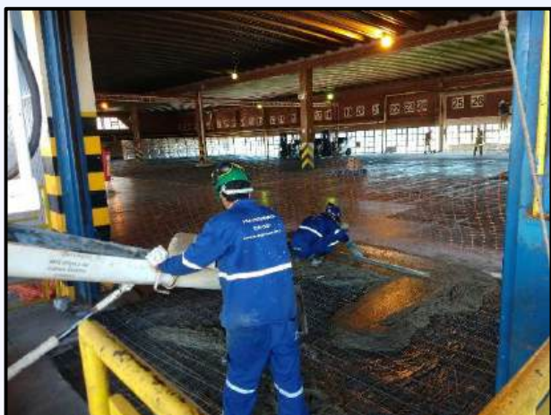
Reparos em Piso de Concreto Armado
