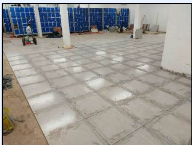
Instalação de Piso Cerâmico em Vestiário
