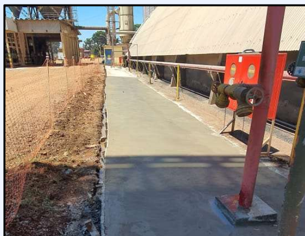
Execução de Piso de Concreto Armado
