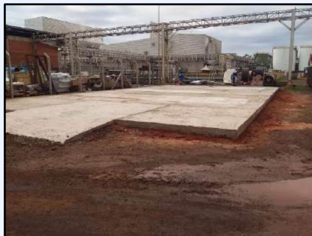
Execução de Piso de Concreto Armado
