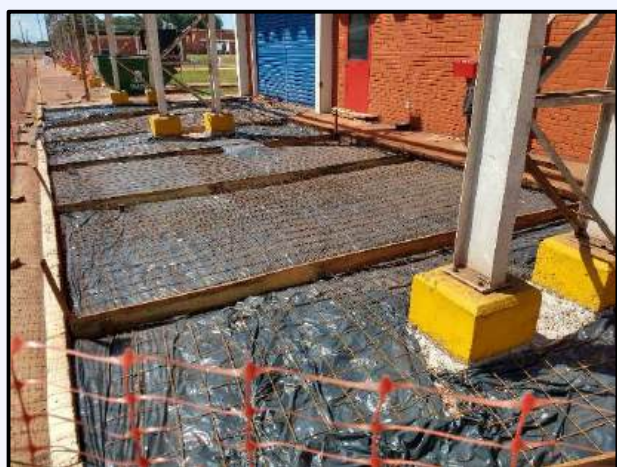
Reparos em Piso de Concreto Armado
