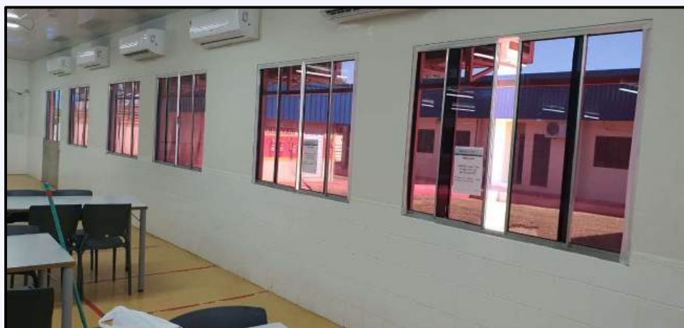
Obras de Reforma em Refeitório
