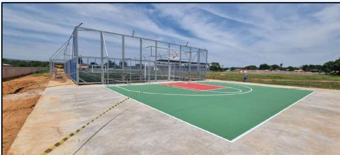
Construção – Obra de Quadra Poliesportiva
