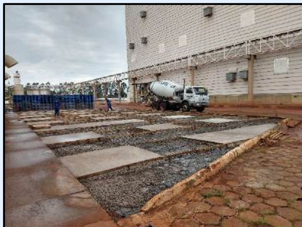
Execução de Piso de Concreto Armado
