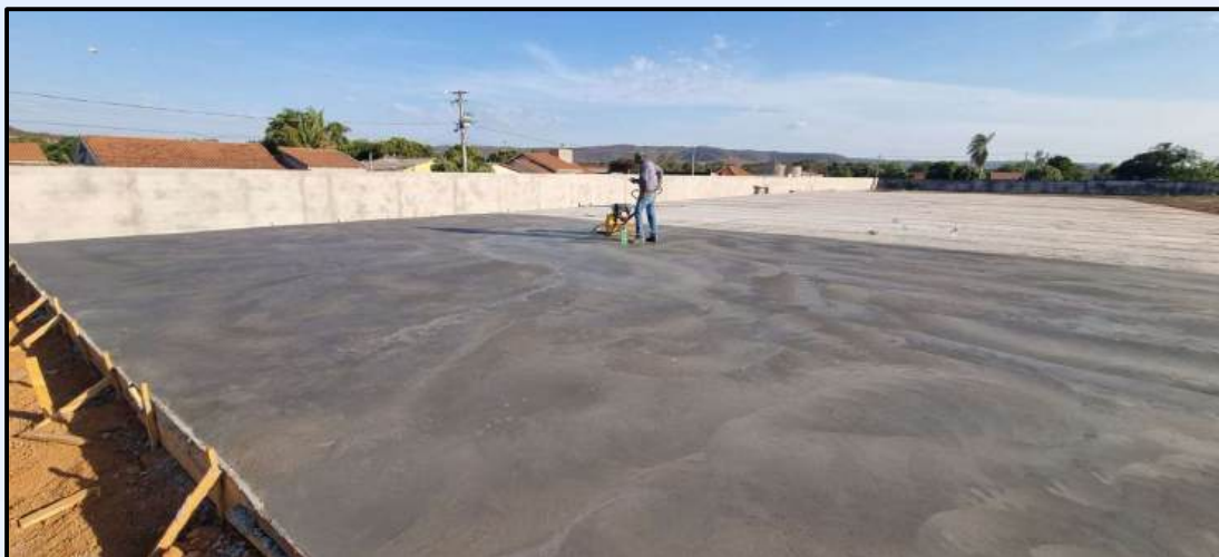
Construção – Obra de Quadra Poliesportiva
