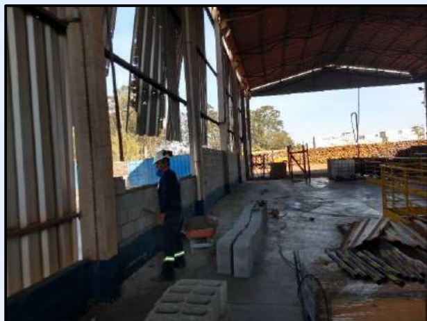
Construção de Parede de Vedação em Blocos de Concreto
