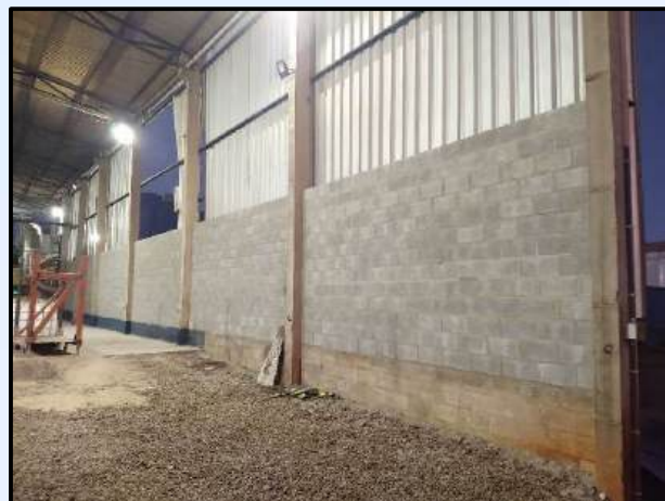
Construção de Parede de Vedação em Blocos de Concreto
