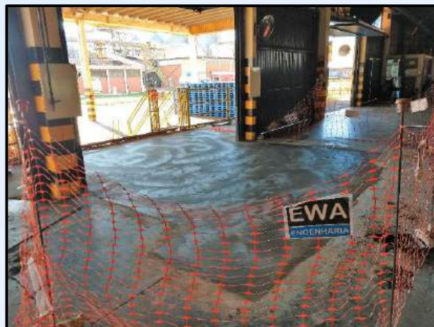
Reparos em Piso de Concreto Armado
