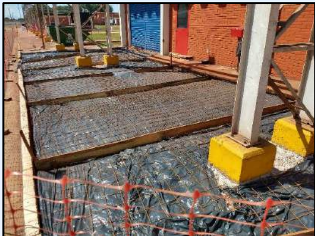
Reparos em Piso de Concreto Armado
