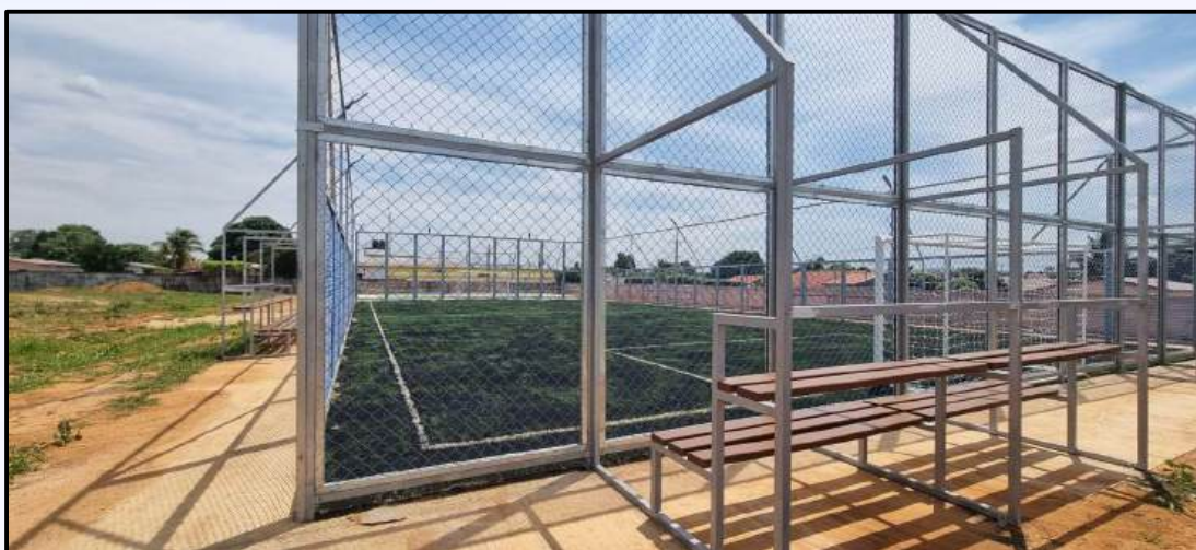
Construção – Obra de Quadra Poliesportiva
