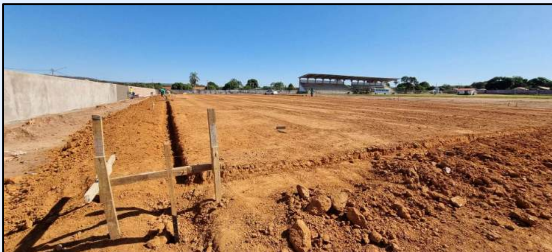
Construção – Obra de Quadra Poliesportiva
