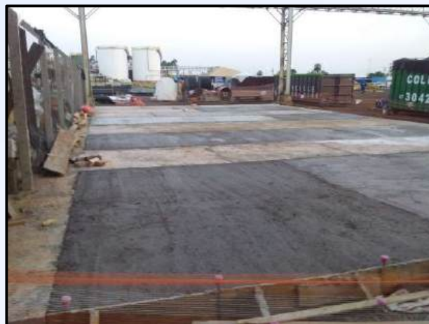
Execução de Piso de Concreto Armado
