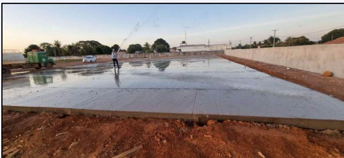
Construção – Obra de Quadra Poliesportiva
