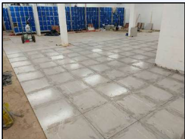
Instalação de Piso Cerâmico em Vestiário
