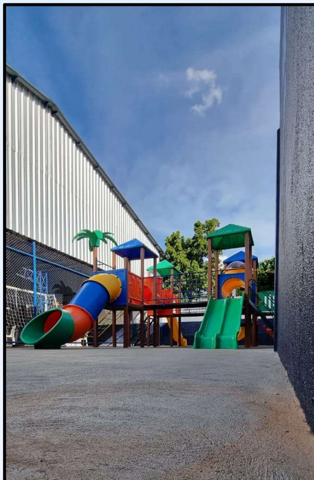
Reforma e Ampliação de Escola
