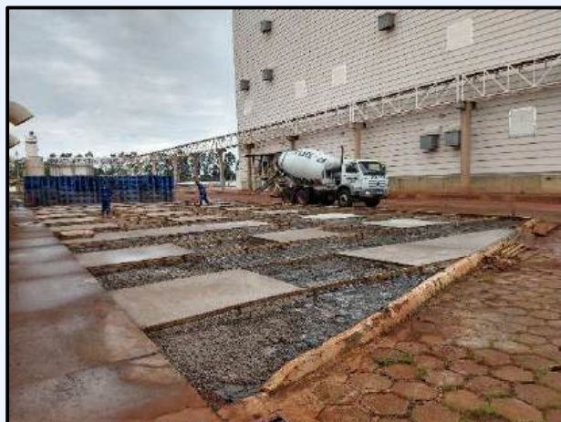
Execução de Piso de Concreto Armado
