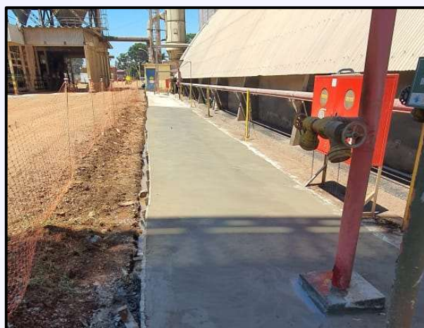
Execução de Piso de Concreto Armado
