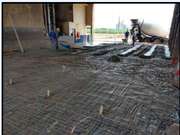
Execução de Piso de Concreto Armado
