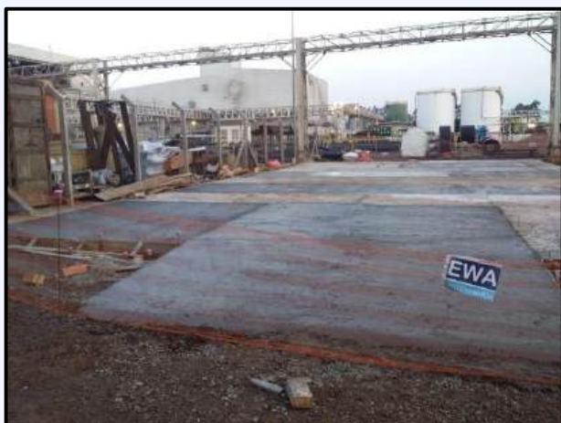
Execução de Piso de Concreto Armado
