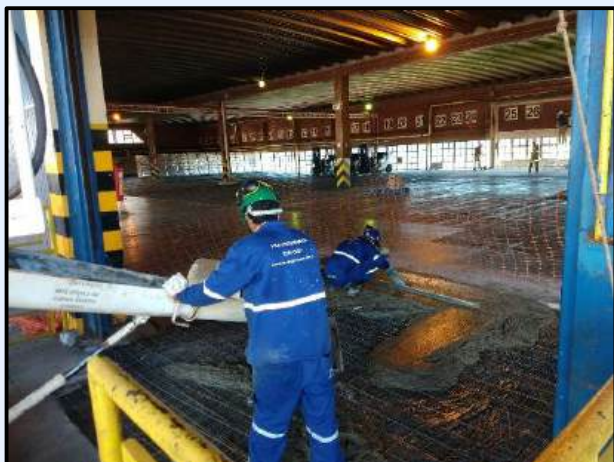
Reparos em Piso de Concreto Armado
