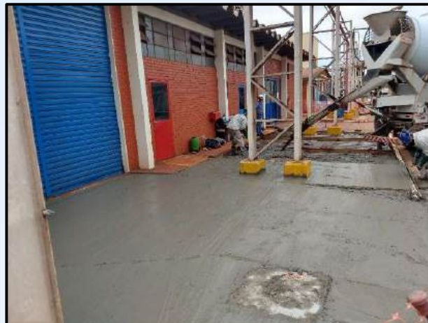
Reparos em Piso de Concreto Armado
