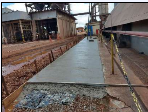
Execução de Piso de Concreto Armado
