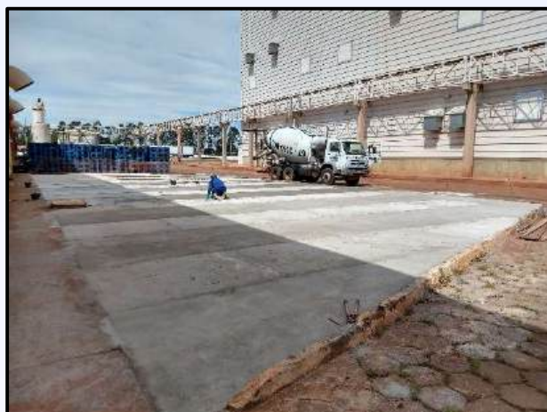
Execução de Piso de Concreto Armado
