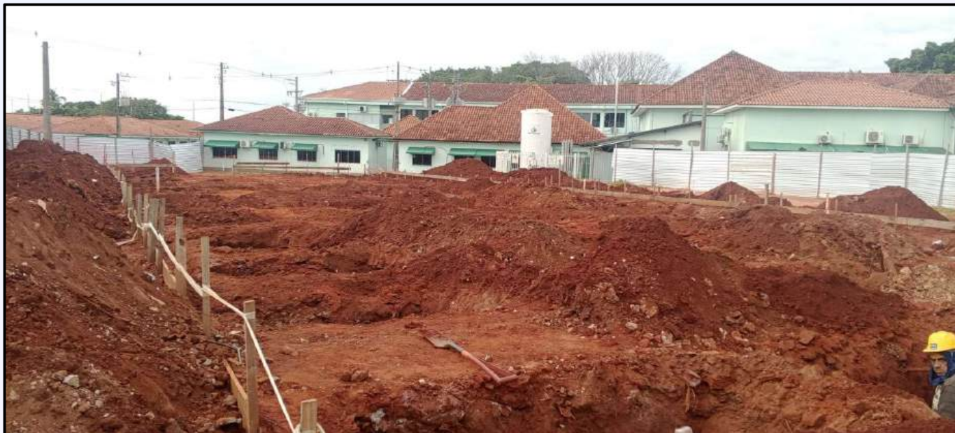
Construção em Andamento – Ambulatório Hospital
