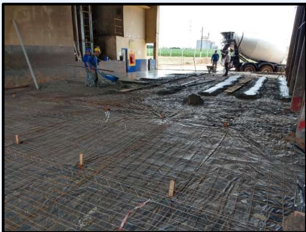
Execução de Piso de Concreto Armado
