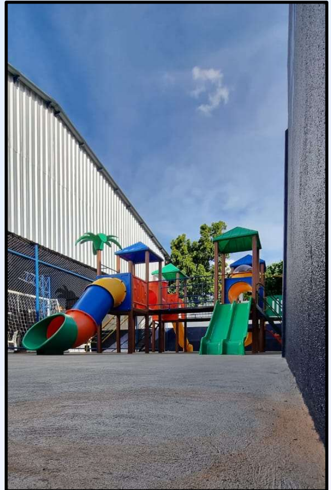
Reforma e Ampliação de Escola
