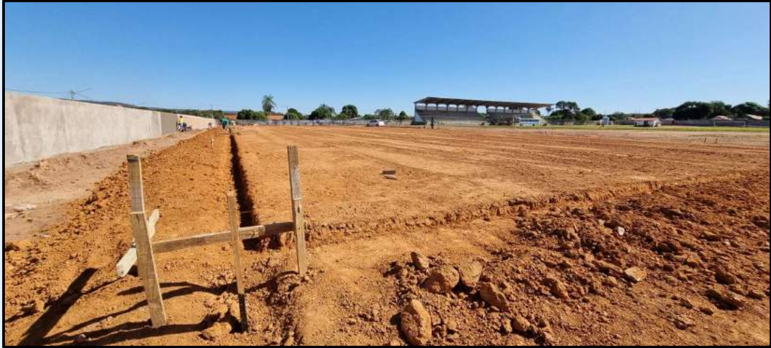
Construção – Obra de Quadra Poliesportiva
