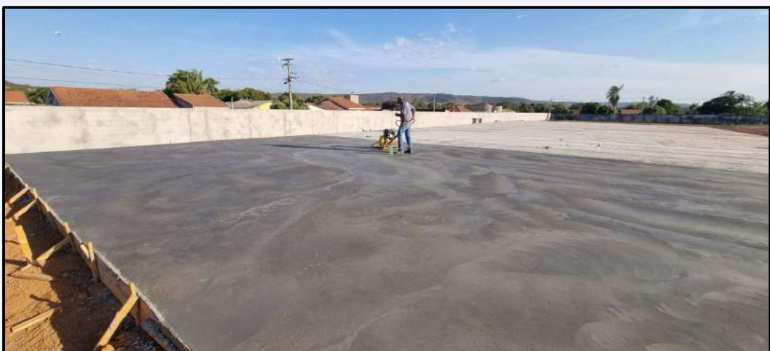
Construção – Obra de Quadra Poliesportiva
