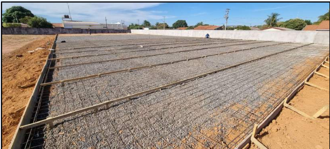
Construção – Obra de Quadra Poliesportiva
