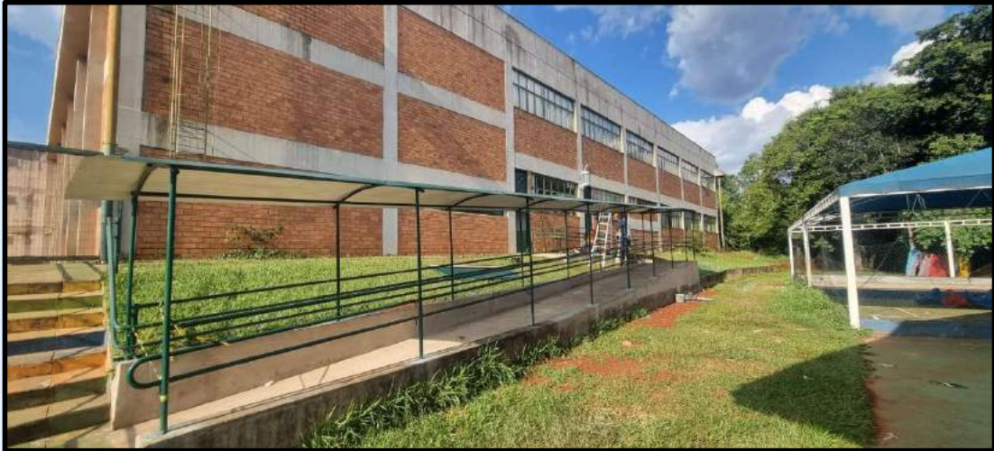
Obras de Adequação, Reforma e Ampliação de Salas de Aula em Universidade
