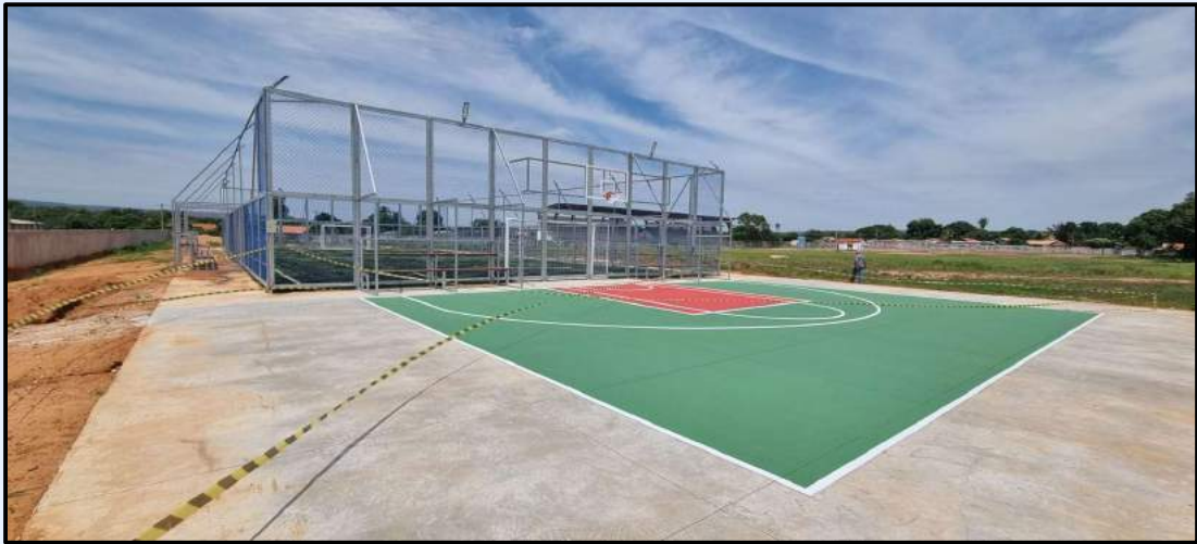
Construção – Obra de Quadra Poliesportiva
