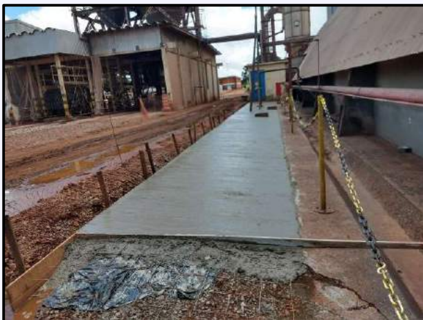
Execução de Piso de Concreto Armado
