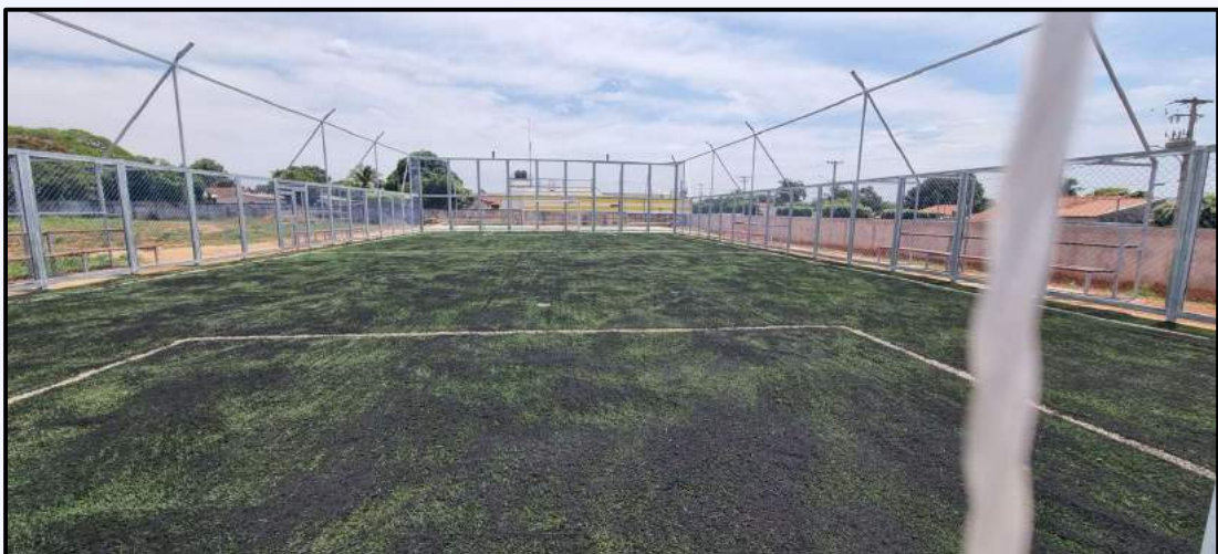
Construção – Obra de Quadra Poliesportiva
