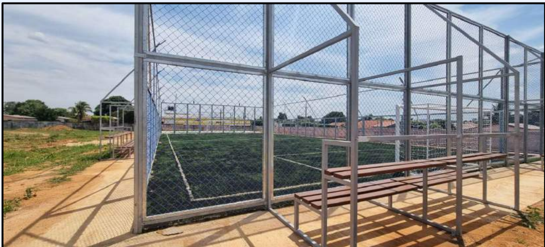
Construção – Obra de Quadra Poliesportiva
