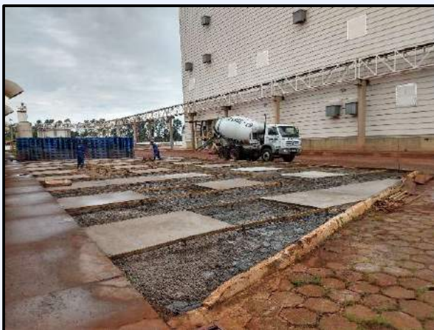
Execução de Piso de Concreto Armado
