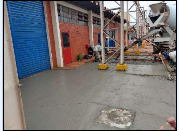
Reparos em Piso de Concreto Armado
