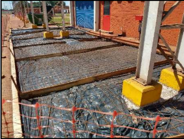
Reparos em Piso de Concreto Armado
