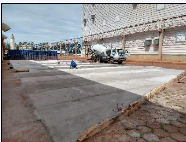
Execução de Piso de Concreto Armado
