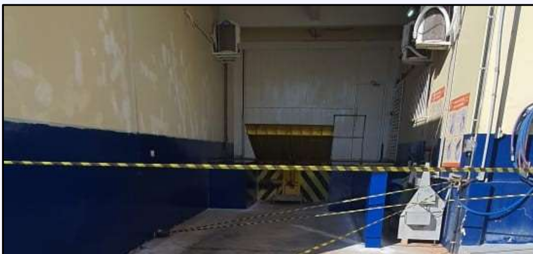
Obras de Adequação de Doca de Recebimento de Insumos
