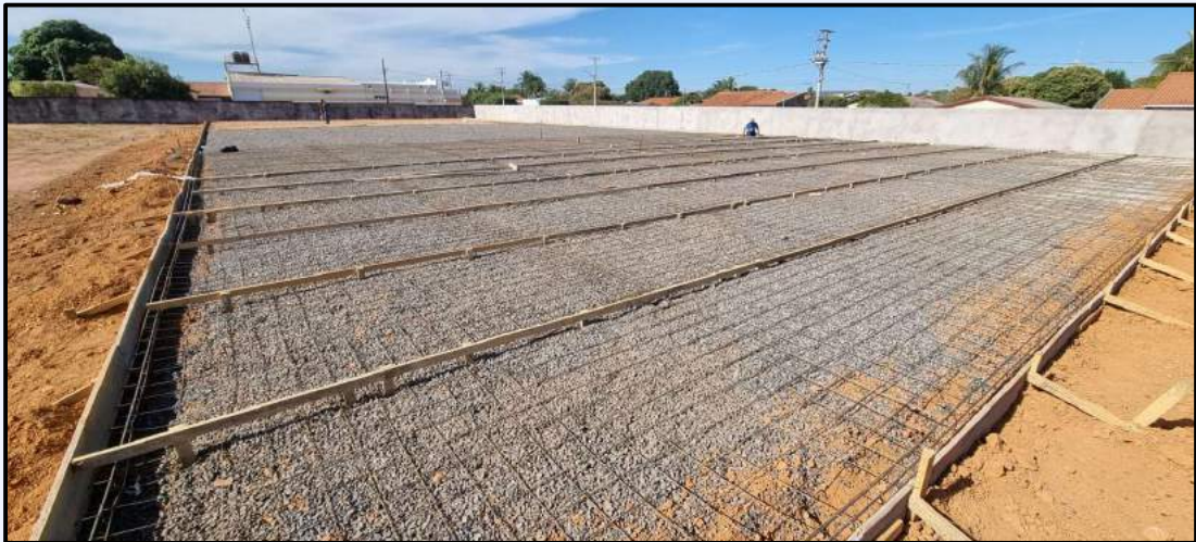
Construção – Obra de Quadra Poliesportiva
