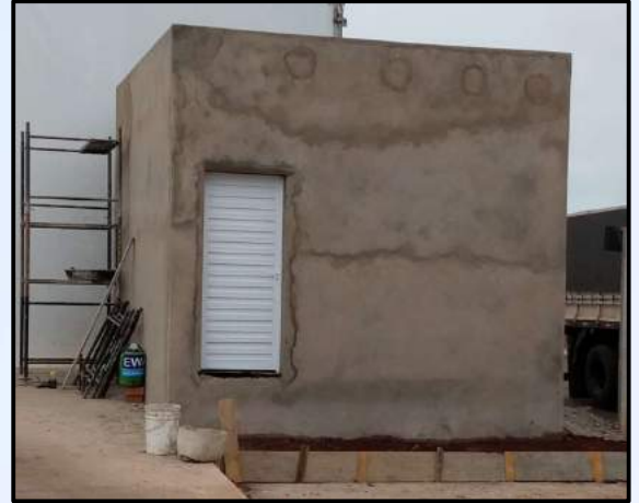
Construção de Edificação em Agroindústria
