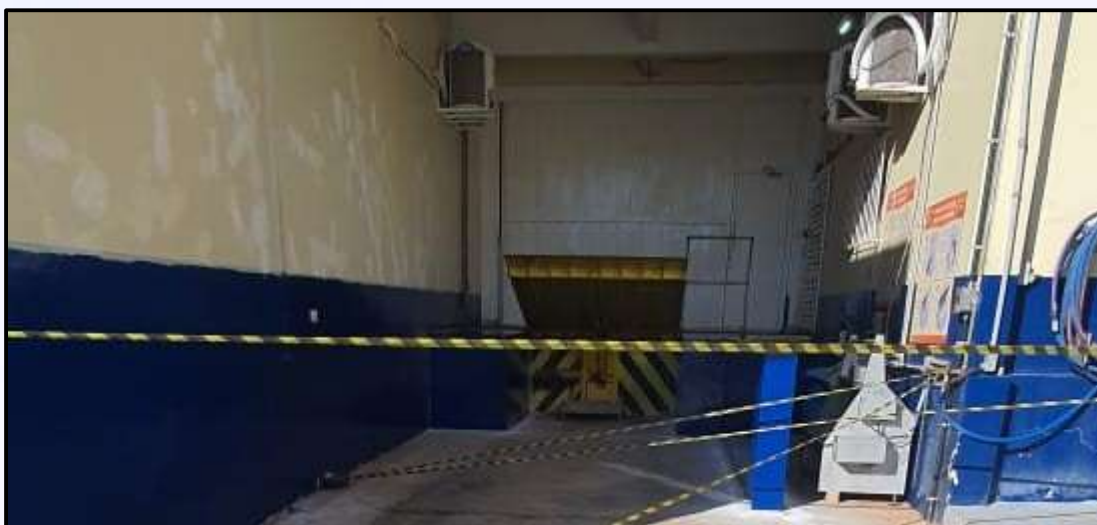
Obras de Adequação de Doca de Recebimento de Insumos em Indústria
