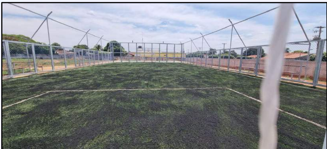
Construção – Obra de Quadra Poliesportiva
