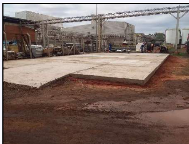
Execução de Piso de Concreto Armado em Indústria
