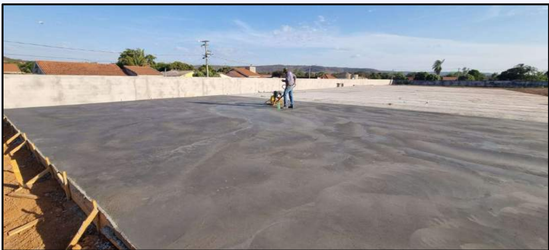
Construção – Obra de Quadra Poliesportiva
