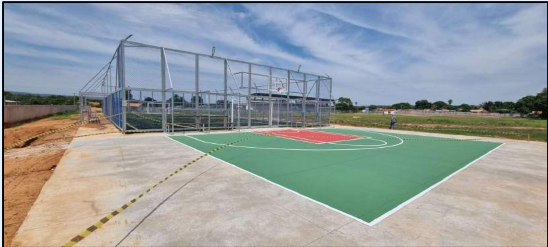
Construção – Obra de Quadra Poliesportiva
