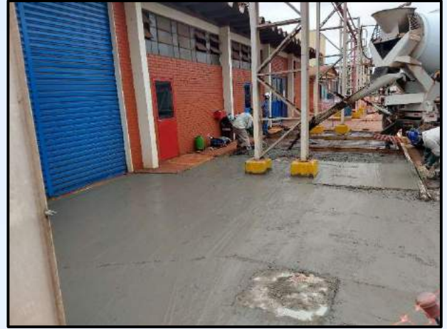
Reparos em Piso de Concreto Armado em Indústria
