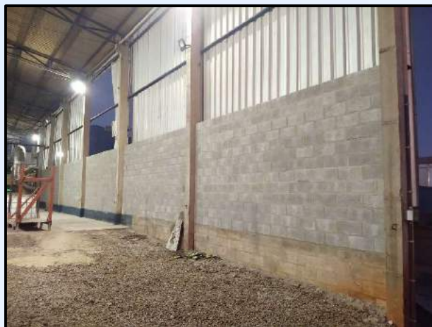
Construção de Parede em Blocos de Concreto em Área de Caldeira
