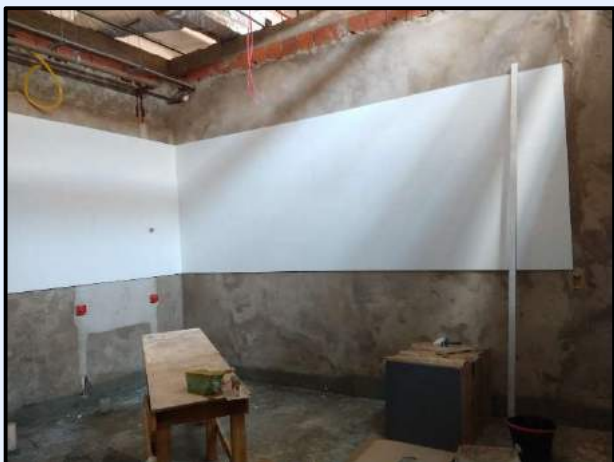
Instalação de Revestimento e Piso Cerâmico em Banheiro de Aeroporto
