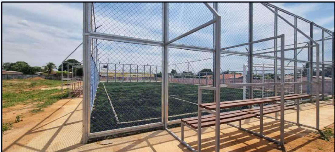
Construção – Obra de Quadra Poliesportiva
