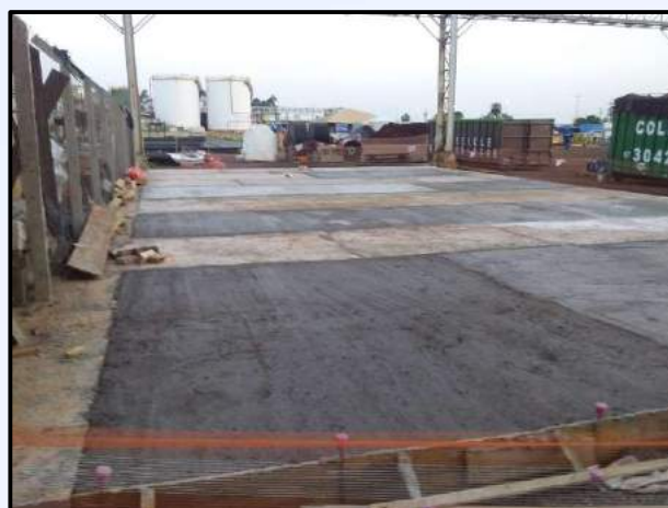
Execução de Piso de Concreto Armado em Indústria
