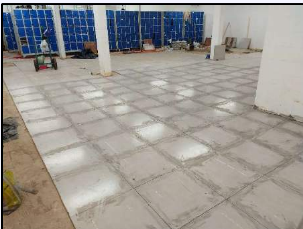
Instalação de Piso Cerâmico em Vestiário de Indústria
