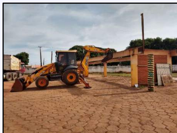
Execução de Demolição de Alvenaria em Área Agroindustrial
