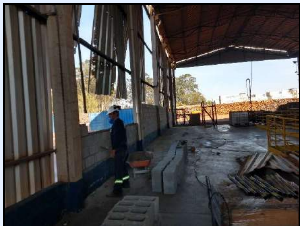
Construção de Parede em Blocos de Concreto em Área de Caldeira
