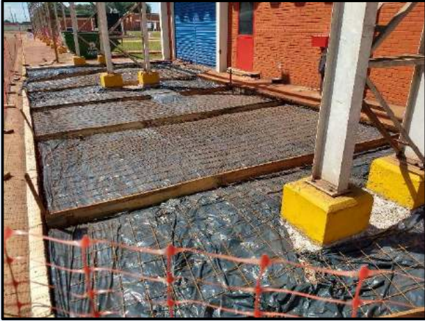
Reparos em Piso de Concreto Armado em Indústria
